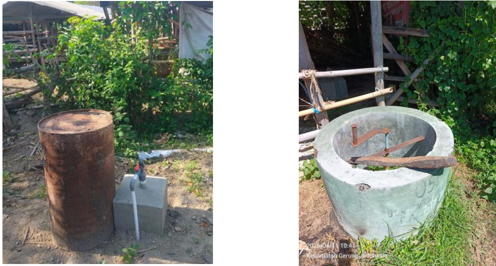
Gambar 3. Kondisi eksisting instalasi digester biogas Kelompok Ternak Male Maju
