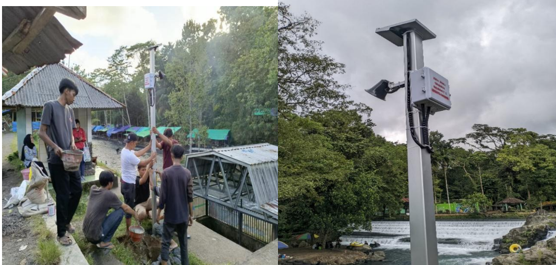
Gambar 3. Unit sirine peringatan dini yang terintegrasi dengan sistem IoT di kawasan hilir.
