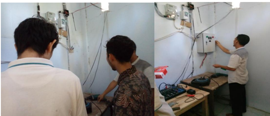
Gambar 5. Proses pemasangan box inverter
